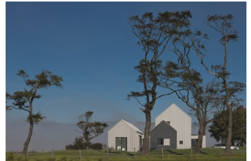
Mit einer Umhüllung aus Titanzink trotzen die drei Gebäude Wind und Wetter. Fotos: Rheinzink
