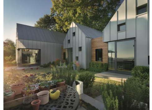
Bei den Satteldächern und Fassaden der fünf kleineren Pavillons dominiert eine durchgehende Linienführung vom First über die Traufe bis zum Boden mit identischen Scharbreiten.
