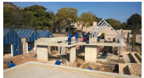
Die Satteldächer der großen Pavillons bestehen aus einem Stahltragwerk. Foto: Paolo Deliperi Architects
