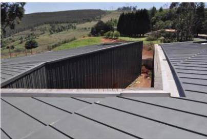
Den unteren Dachabschluss bildet eine innenliegende Regenrinne. Die Abdeckung der Rinnen dient gleichzeitig als oberer Abschluss der Fassadenbekleidung.
