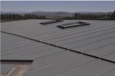
Für die Dacheindeckung setzte der Verarbeiter bis zu 16 Meter lange Schare ein. Die Eindeckrahmen der Oberlichter hat der Verarbeiter separat gefertigt und vor Ort eingelötet.
