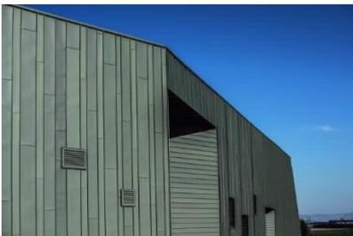
Die unterschiedlich breiten Schare (300, 400 und 500 Millimeter) gliedern die Fassade vertikal. Gebäudeeinschnitte hat der Verarbeiter durch horizontale Verlegung hervorgehoben.
