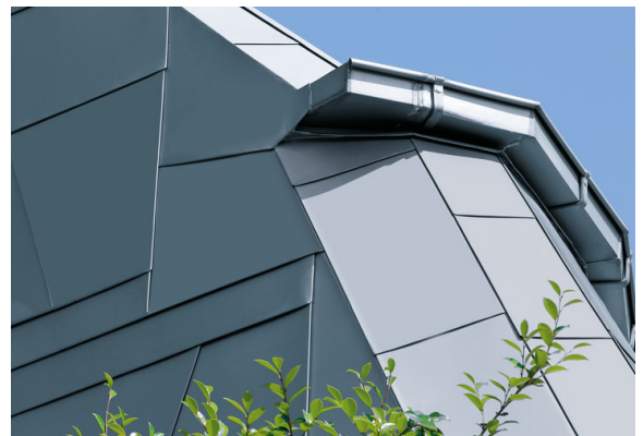
((Datei: 2348-049-A4-RET.tif)) Kastenförmige Entwässerung – um die Ecke montiert. Foto: Rheinzink
