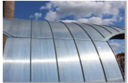
Die durchlaufenden Querfalze und Ableitungen der dreiteiligen Auslaufrinnen.
