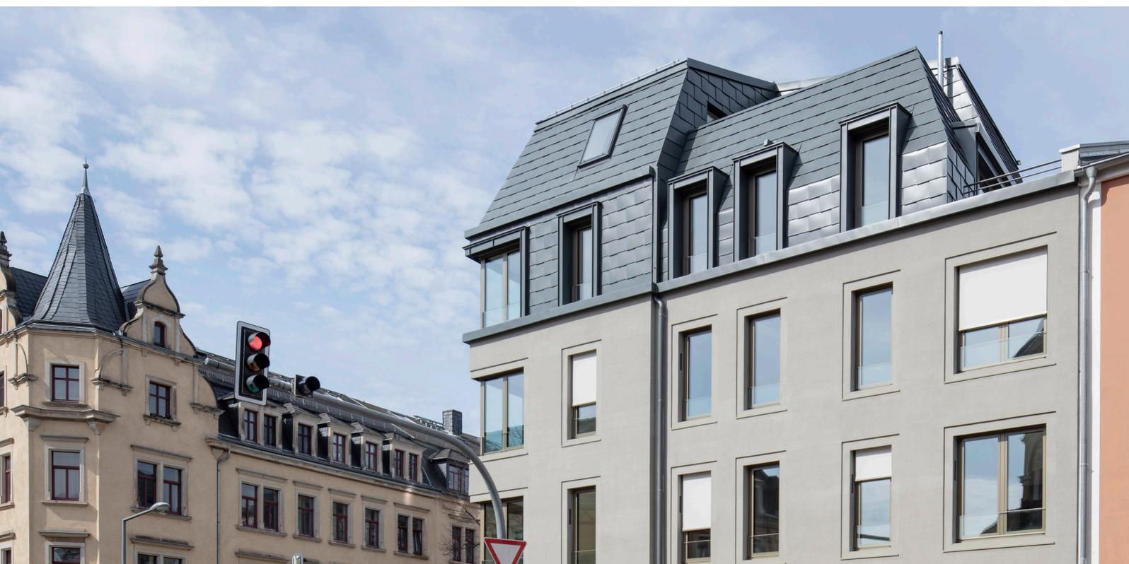
So ist die Oberfläche beispielsweise lötbar und unterliegt auf dem Dach der natürlichen Patinabildung. Der Neubau mit seiner modernen Interpretation der betonten Gebäudeecke und des Mansarddachs wird sich dadurch im Laufe der Zeit immer mehr zu einem organischen Bestandteil der Gründerzeitbebauung im Dresdner Norden entwickeln.
