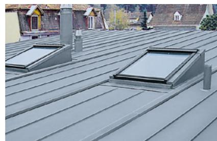
**Dachdurchbruch mit beidseitigem Anschluss in Dehnungsleisten**
