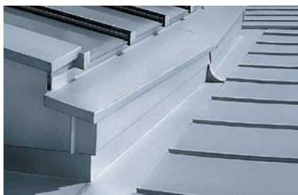
**Anschlüsse im Nackenbereich mit dicht aufgesetzten Einhängestreifen und hinterem Umschlag, um eine ungehinderte Ausdehnungsmöglichkeit der Blechbahnen zu gewährleisten**
