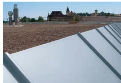
Ästhetische RHEINZINK-Bekleidung und Schutzschicht des Flachdaches
