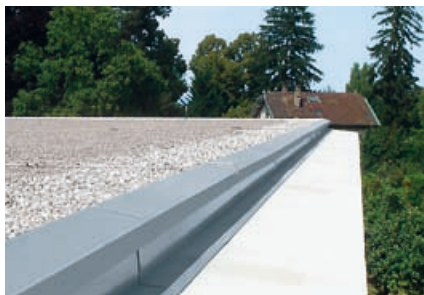
Vu d'en bas, un raccord au toit plat invisible
