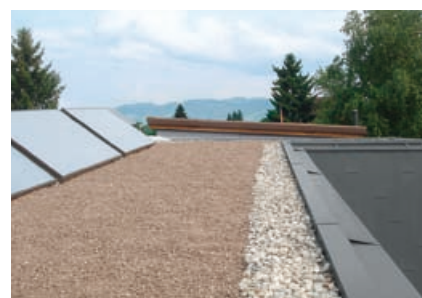
Toit plat avec capteurs solaires, bord de toit et façade à bardeaux RHEINZINK
