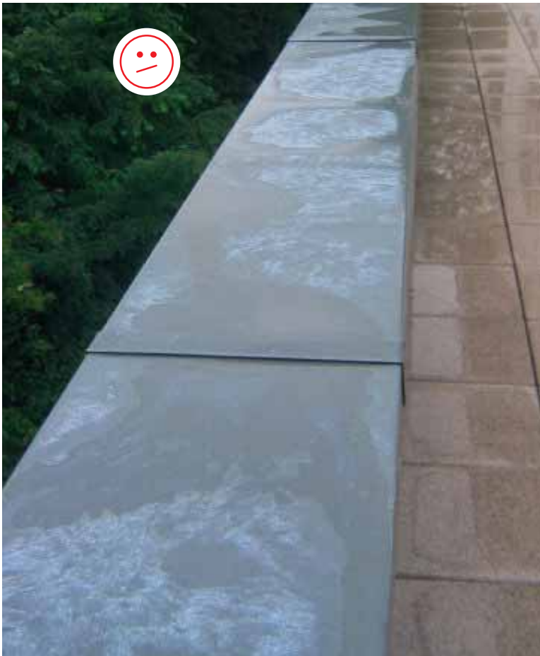
Bildung von Zinkhydroxid durch unzureichendes Gefälle
