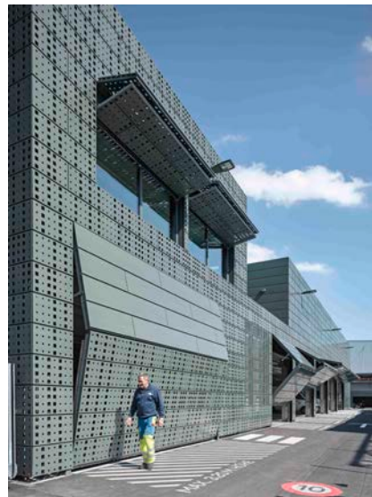
((Datei: illiz_UNTERWERK_a07_frei)) Werktags öffnet sich das Gebäude wie ein überdimensionaler Werkzeugkasten und präsentiert mit Falttoren und Fallläden seine überirdische Nutzung. Foto: Roger Frei, Zürich
