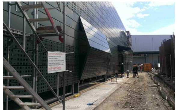
((Datei: Unterwerk_WP_20150623_043)) Die Fertigmaße der Kassetten variierten in der Breite zwischen ca. 850 und 3000 mm. Foto: illiz Architektur
