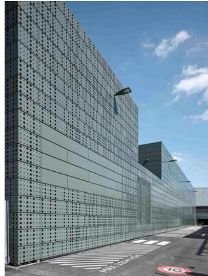
((Datei: illiz_UNTERWERK_a08_frei)) Die schiefergrauen Kassetten hüllen das Gebäude nahezu komplett ein. Foto: Roger Frei, Zürich
