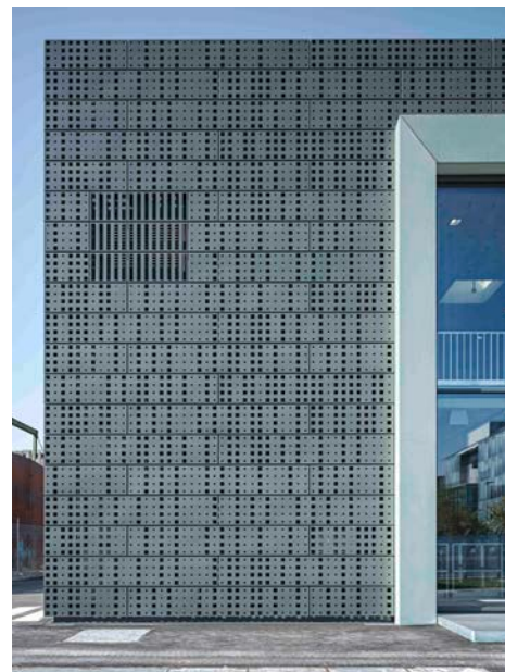
((Datei: illiz_UNTERWERK_a05_frei)) Die Kassetten sind mit vier unterschiedlichen Lochungsdichten ausgestattet und in einem von den Architektinnen vorgegebenen Muster an der Fassade montiert wurden. Foto: Roger Frei, Zürich
