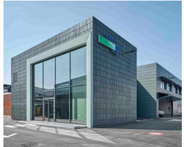
((Datei: illiz_UNTERWERK_a03_frei)) Der großflächig verglaste Haupteingang (links) bildet das architektonische Pendant zum Guckkasten (rechts). Beide sind mit grün eingefärbtem Beton umrahmt. Foto: Roger Frei, Zürich
