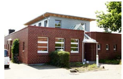
((Datei: L+L Dachtechnik GmbH_Herr Lorant_58.jpg)) Das Übungsgebäude der Feuerwehr in Dülmen wurde mit einer Aufstockung erweitert, deren Titanzink-Fassade heute einen spannenden Kontrast zur vorhandenen Klinkerfassade bildet.
