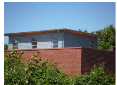
((Datei: Feuerwehr Duermen SPLine.jpg)) Die neuen Räume auf dem Dach wirken optisch leicht und belasten durch die Holzbauweise und die leichte Fassade die ursprüngliche Konstruktion nur in geringem Umfang.
