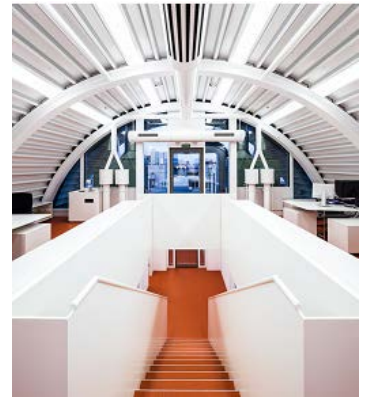
Metall prägt mit dem sichtbar bleibendem Stahltragwerk und den weiß beschichteten Trapezprofilen auch die Innenansicht der Büroräume unter dem Tonnendach. Foto: RHEINZINK
