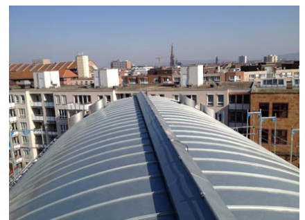
Blick über den First des neuen Tonnendachs auf dem Stadtarchiv in Karlsruhe. Foto: Thomas Schmidt
