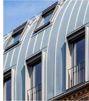
Mit durchlaufenden Scharen zwischen den Fenstern und optisch unauffälligen Querfalzen unterstreicht die Deckung die Tonnenform des Dachs. Foto: RHEINZINK
