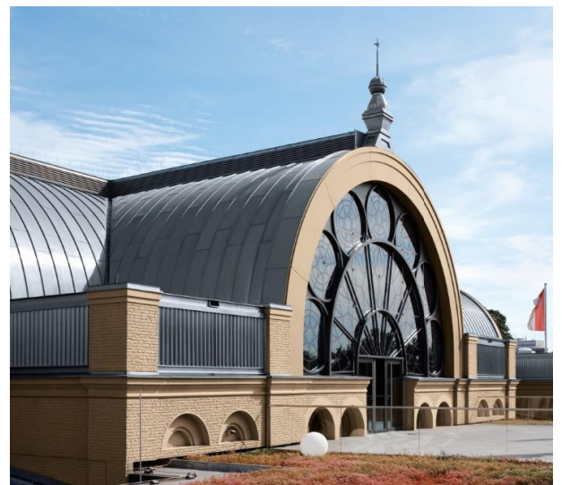
((Datei: 2345-039-A4-RET.tif)) Eine spezielle Lamellenkonstruktion am First sorgt für die Belüftung der Metalldachkonstruktion. Foto: RHEINZINK
