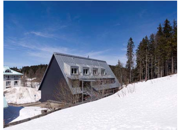
Dachansicht von der Bergseite mit überdachtem Zugang zu den Gästewohnungen.
