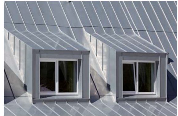
Sorgfältig und fachgerecht ausgeführte Details schaffen ästhetische Ansichten mit sauberen Linienführungen.
