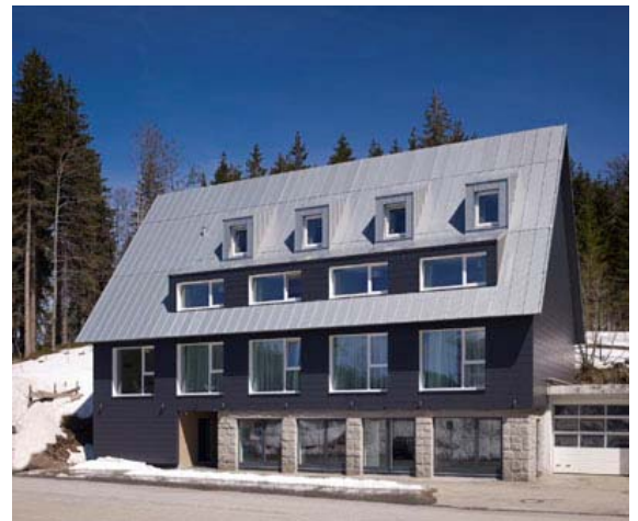
Das ruhige Linienbild der Stehfalzdeckung trägt zur klaren Architektur bei. Auf eine Dachentwässerung wurde wegen des starken Schneefalls ebenso verzichtet wie auf Schneefänge.
