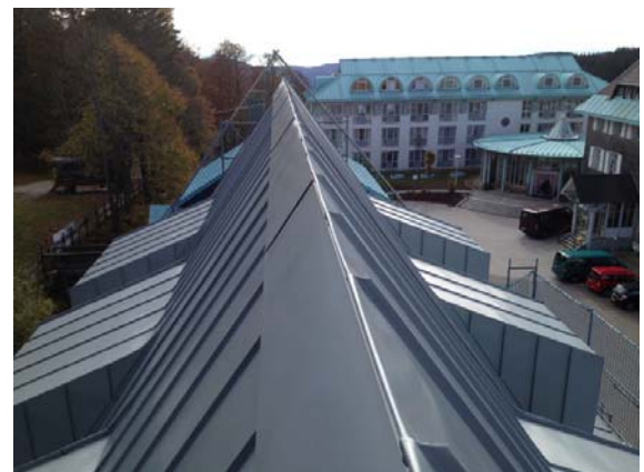
Aus der Bauphase: Detailausbildung am First.
