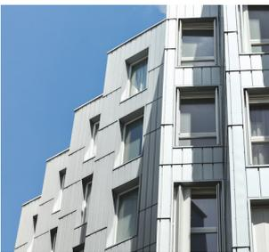
Schmale senkrechte Elemente mit einer markanten horizontalen Stoßfuge in Titanzink prägen die Fassade.
