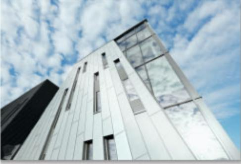
Schmale senkrechte Titanzink-Elemente in Winkelstehfalztechnik prägen die Fassade.
