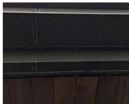
Exemples de dépôts de sel sur les sous-faces et dessous de gouttières
