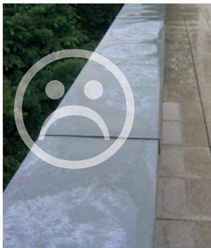
Formation d'hydroxyde de zinc due à une pente insuffisante
