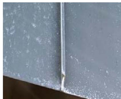
Exemples de dépôts de sels sur les façades, les joints et les égouts
