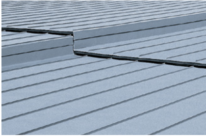
Quernaht als Gefällestufe
