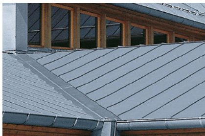
Kehle mit Einfach- und Zusatzfalz
