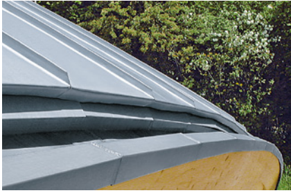
Traufe auf Holzschalung ohne strukturierte Trennlage
