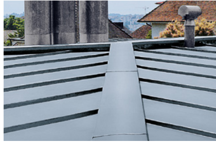
Grat mit breiter Abdeckung wie First, mit oder ohne Belüftung
