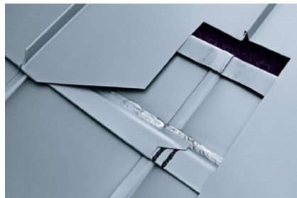
Detailoptimierung: Zusatzhaftstreifen
