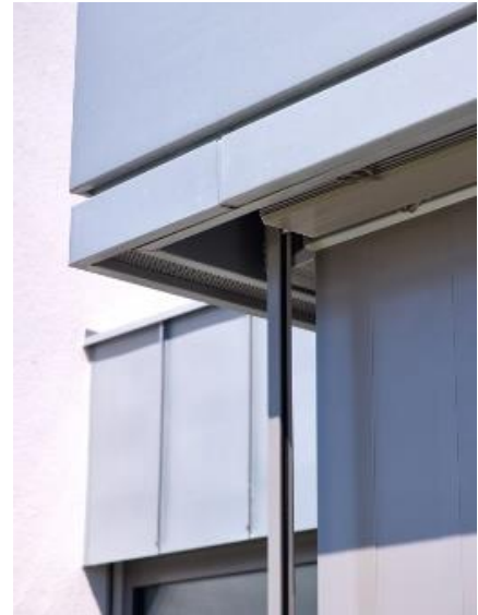
((Datei: 2359-061_web)) Die Fassadenbekleidung wurde mit dem Steckfalzpaneelsystem, die Dachdeckung mit Doppelstehfalzpaneelen realisiert. Foto: RHEINZINK
