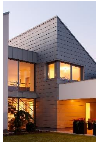
((Datei: 2359-093_web)) Der zurückgesetzte Flachdachtrakt verbindet im Innern und von außen die beiden Haushälften. Foto: RHEINZINK
