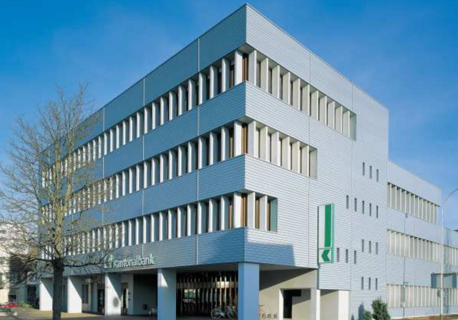
Fassadensanierung Thurgauer Kantonalbank, CH-Weinfelden; Architekten: Tanner + Partner, CH-Winterthur; Fassadenplanung: F. Müller, CH-Bussnang
