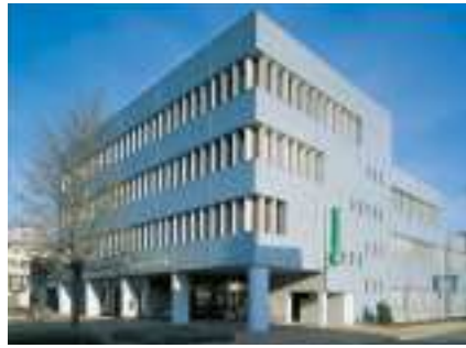
Die Thurgauer Kantonalbank nach Fertigstellung der RHEINZINK®-Paneelfassade
