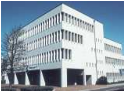
Die Thurgauer Kantonalbank vor der Sanierung
